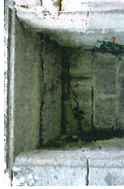
Puits en pierre de taille, couvert en dalles
