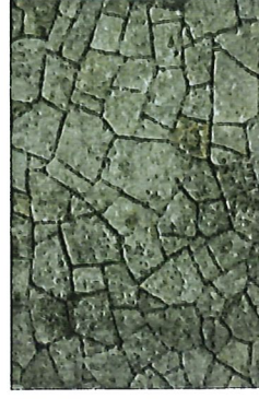
Mur de Murzeix
